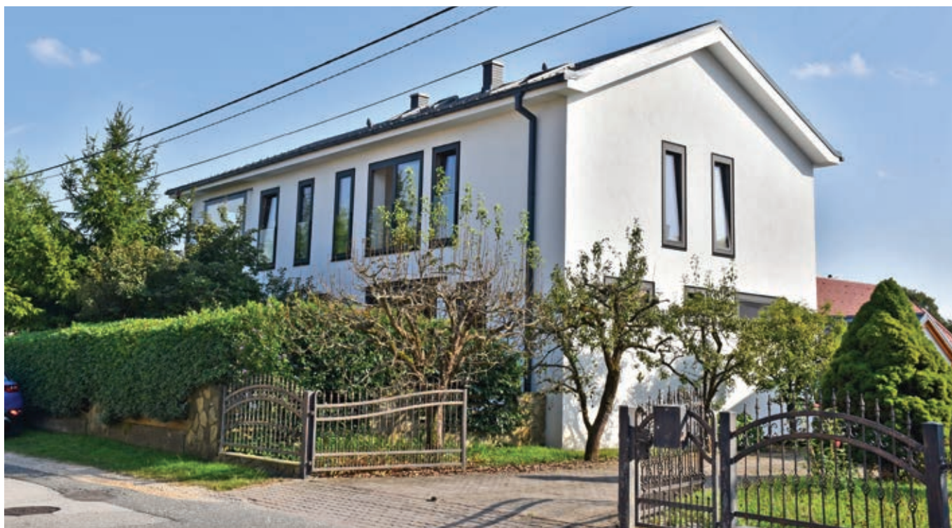
Druga prenova stavbe - izvajalka Maruška Reiter (roj. Završki) ...
