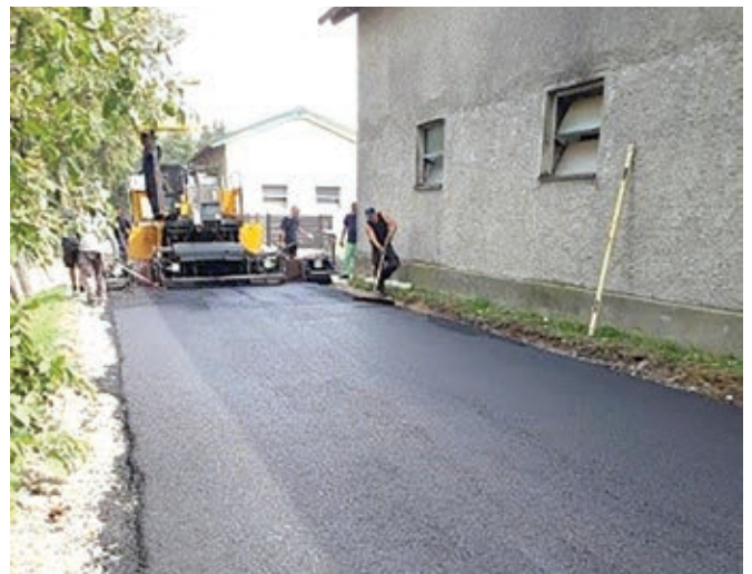
Položen asfalt v Zlatoličju ...
