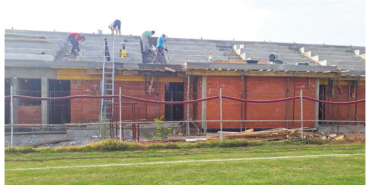
Dela potekajo po načrtu ...
