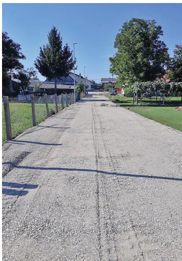
Zaenkrat kot gradbiščna cesta ...
